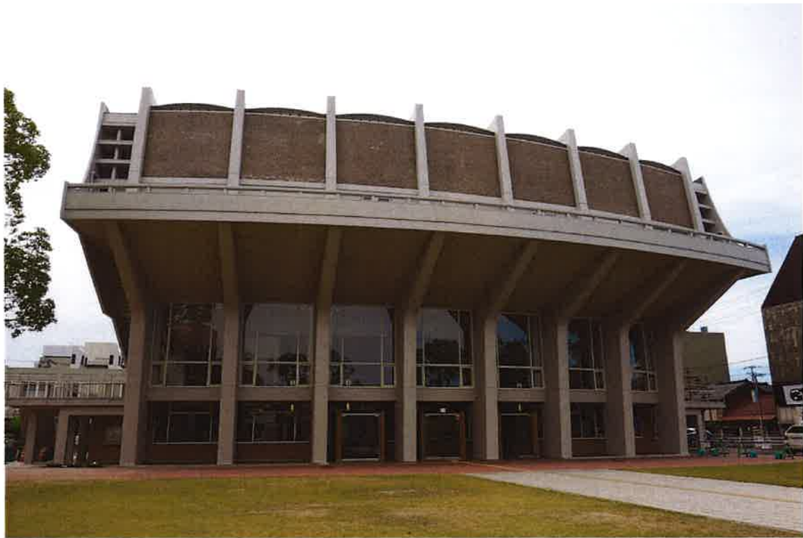
図5 米子市公会堂 外観（改修後）
